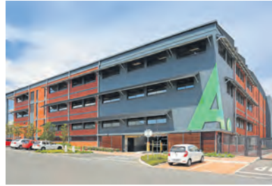
Die gebou spog met 'n nywerheidsgevoel.
