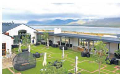
Die onderdakpaadjie langs die binnehof waar gaste beskut van die elemente buite kan ontspan.
