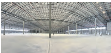
Die vloer van gewapende staalvesel skep 'n oppervlak met minder laste wat minder instandhouding verg.
